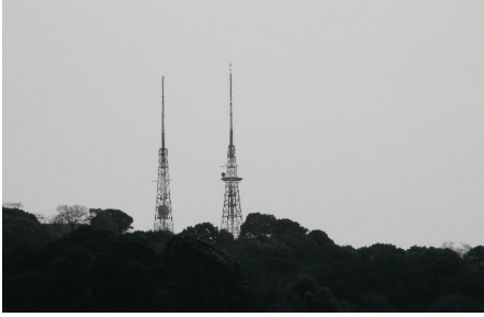
Les deux antennes du Radiation Effects Research Foundation, Hijiyama-Park, Hiroshima
